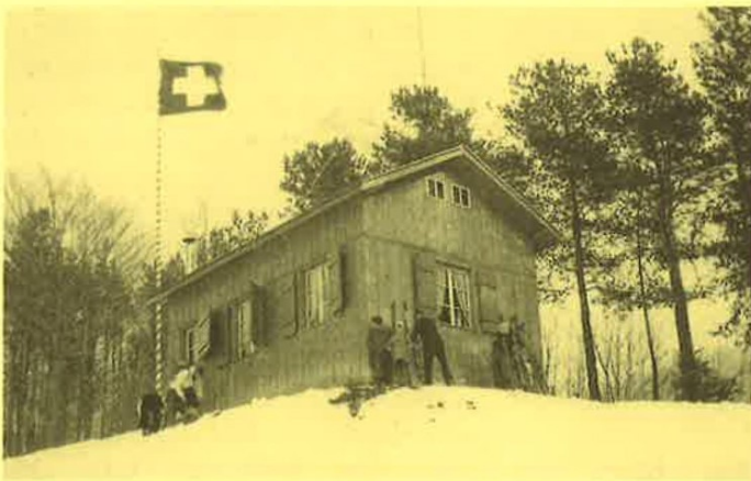
Die Skihütte an der Lägern
