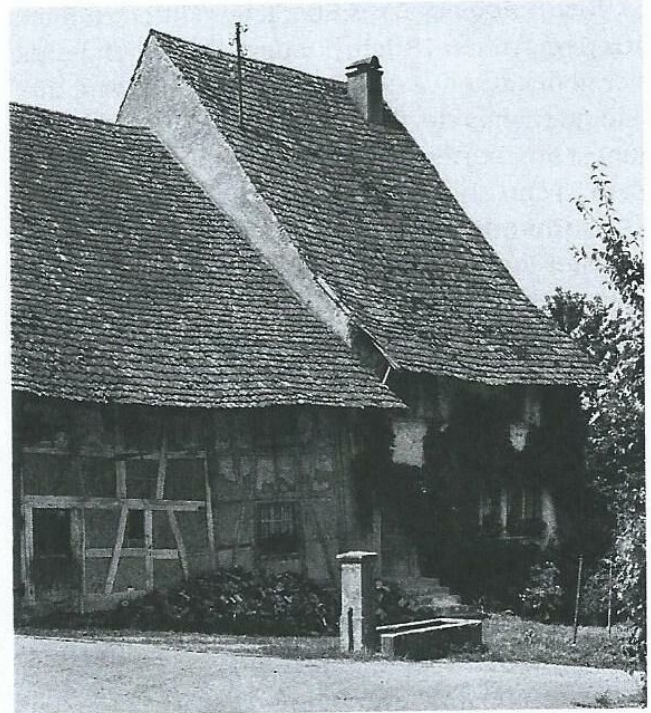
Abb. 161 Unterehrendingen. Haus Oberdorf Nr. 7. Wohntrakt (rechts) 1695, Stallscheune 18. Jh. Ansicht von Südosten. Aufnahme 1971. – Text nebenan.
