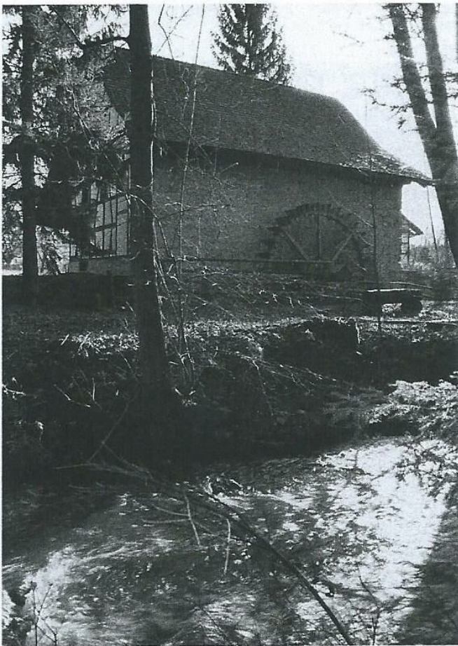
Abb. 165 Unterehrendingen. Ehemalige Gipsmühle (Tiefenwaag Nr. 57). Ansicht von Norden. – Text S. 161.
