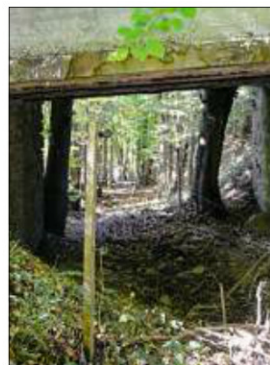
Das Trasse der Schienenbahn ist im Gelände noch gut sichtbar
