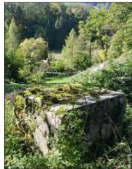
Der alte Betonsockel oberhalb der ehemaligen Zementfabrik
